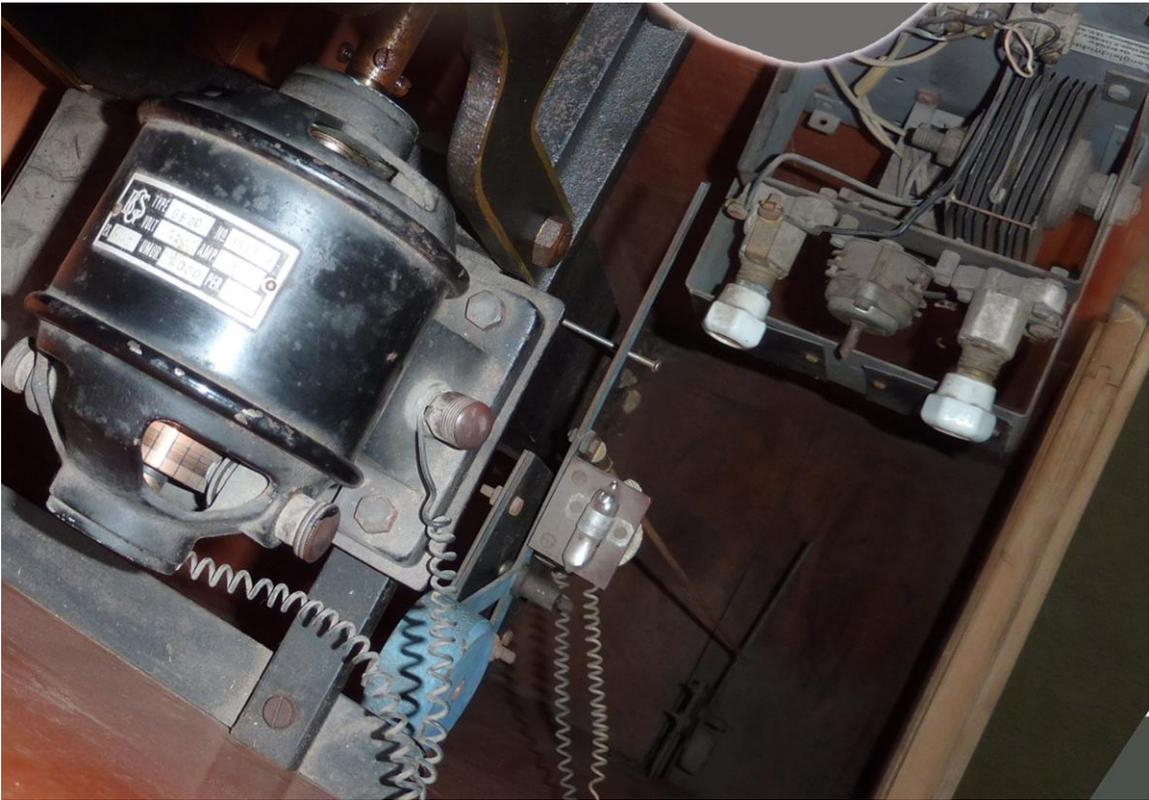
Aufzugsteuerung und Gleichspannungsversorgung
