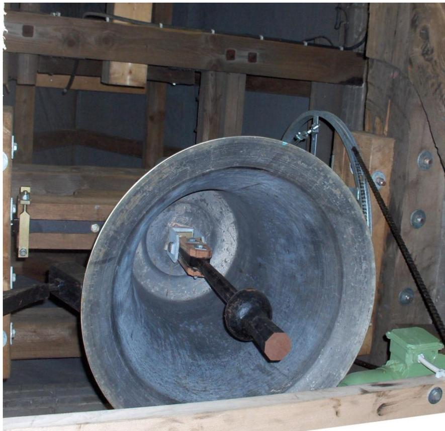
Mit der Lätemaschine mit Quarzuhr und Funkkorrektur über den DCF-Sender, der sein Signal von der PTB in Braunschweig erhält, kann man u.a. Beginn und Dauer des Lätens an dem unteren Teil der Anlage programmieren. Sie läutet z.B. täglich um 18 Uhr. Ursprünglich wurden die Glocken von Hand geläutet.
